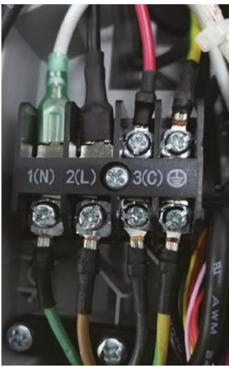
El bloque terminal de la unidad interior recibe potencia eléctrica desde la unidad exterior. Hay 4 conexiones para los cables eléctricos. Las terminales 1 y 2 están conectadas a las terminales 1 y 2 de la unidad exterior. El cableado le suministra potencia a la unidad interior.
