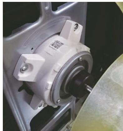
El motor del ventilador exterior es un motor de velocidad variable. La velocidad del motor requerida es calculada por la Placa de Control Principal. El motor se encuentra eléctricamente conectado a la Placa de Control Principal a través del ENCHUFE CN-21.
