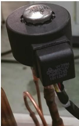
El dispositivo de medición es una válvula de expansión electrónica de tipo EEV. La válvula consta de un operador eléctrico y un cuerpo de válvula con orificio interior de tamaño variable. Cuando esté en funcionamiento, la Placa de Control Principal enviará pulsos de voltaje al operador eléctrico. Luego, el operador moverá de forma magnética la posición de la clavija del orificio de medición para variar su tamaño.
