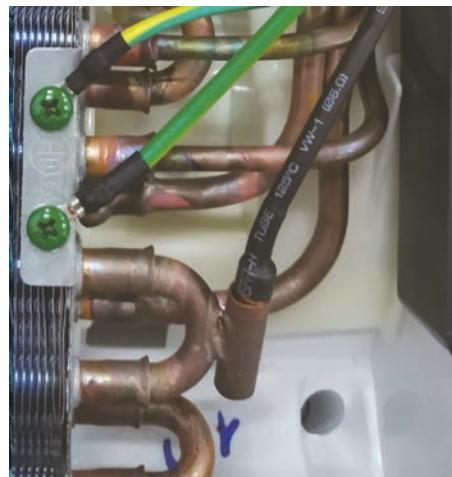
La sonde de température du serpentin consiste en un thermistor à coefficient négatif dont la résistance diminue avec l'augmentation de la température du serpentin. La sonde est située dans un logement soudé sur la surface du serpentin intérieur.
