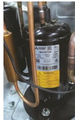
El compresor es un inversor de CC de tres fases con conducción de Rotación. El compresor posee la capacidad de funcionar con velocidad variable. La frecuencia de funcionamiento del compresor será determinada por la diferencia de temperatura entre el punto de configuración y la sala o la temperatura del aire exterior. (Modo de Frío versus Modo de Calor)
