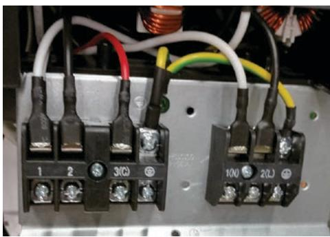
L'unité extérieure est alimentée par une tension monophasée de 208/230 volts connectée au bornier de l'unité extérieure. Les bornes 1 et 2 sur le bornier de l'unité extérieure connecte cette tension au système. La borne 3 est une borne de communication qui connecte le câblage entre les unités intérieure et extérieure. Une borne de source de mise à la terre connecte l'unité extérieure à une source d'alimentation de tension de secteur.
