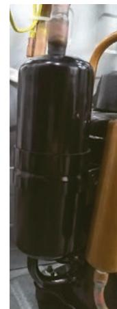
El Acumulador está ubicado en el circuito de la tubería de succión en la entrada al compresor. El acumulador ayuda a evitar que el líquido refrigerante ingrese al compresor durante el funcionamiento.
