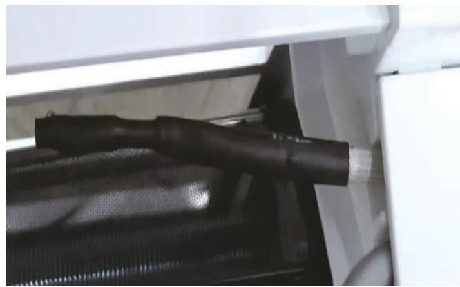
El Sensor de Temperatura Ambiente de la Sala es un termistor de coeficiente negativo que reducirá su resistencia al haber incrementos en la temperatura del aire de la sala. El sensor se encuentra ubicado en un sujetador montado sobre la superficie de la bobina interior.
