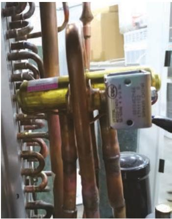
La Válvula de 4 Vías redirige el flujo de refrigerante a través del circuito de la tubería para permitir que el sistema intercambie las funciones de las bobinas interior y exterior. Cuando esté desactivada en COOL MODE (Modo de Frío), la válvula dirigirá el gas caliente del refrigerante hasta la bobina exterior. Cuando esté activada en HEAT MODE (Modo de Calor), la válvula dirigirá el gas caliente hasta la bobina interior.
