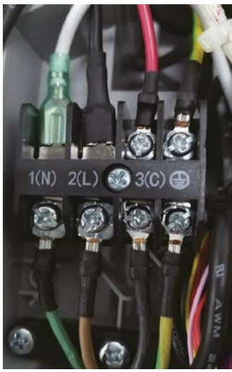
Le bornier de l'unité intérieure reçoit l'alimentation électrique de l'unité extérieure. Il y a 4 connexions pour les câbles électriques. Les bornes 1 et 2 sont connectées aux bornes 1 et 2 de l'unité extérieure. Ce câblage fournit l'alimentation à l'unité intérieure.
