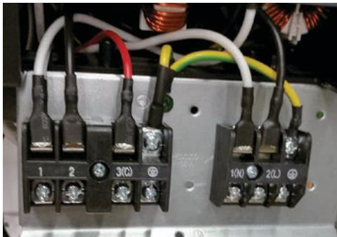
La unidad exterior es alimentada eléctricamente por una Fase Simple de 208/230 Voltios, conectada al Bloque Terminal de la Unidad Externa. Las terminales 1 y 2 de la terminal de la unidad externa conectan este voltaje al sistema. La terminal número 3 es una terminal de comunicación que conecta el cableado entre las unidades exterior e interior. Una terminal con fuente de conexión a tierra conecta la unidad exterior con la fuente de encendido de la línea voltaje.
