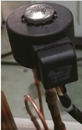
Le dispositif de mesure consiste en un détendeur électronique (ang. EEV). Le robinet consiste en un actionneur électrique et un corps à orifice interne de diamètre variable. En fonctionnement, la carte de commande principale envoie des impulsions de tension à l'actionneur électrique. Par magnétisme, l'actionneur change alors la position de la tige de l'orifice du dispositif de mesure afin de varier son diamètre.
