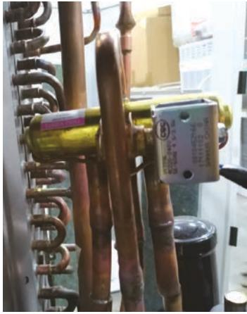
Le robinet à quatre voies redirige la circulation de réfrigérant dans le circuit de tuyauterie pour permettre au système de permute les fonctions des serpentins intérieur et extérieur. Lorsqu'il est hors tension en MODE CLIMATISATION, le robinet redirige le gaz chaud du réfrigérant au serpentin extérieur. Lorsqu'il est sous tension en MODE CHAUFFAGE, le robinet dirige le gaz chaud au serpentin intérieur.
