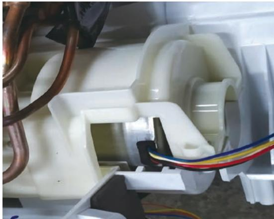
Le moteur de ventilateur intérieur est à vitesse variable. Le moteur varie sa vitesse selon la vitesse de l'onduleur du compresseur. La vitesse peut aussi se régler à la télécommande ou automatiquement à l'aide du mode ventilateur AUTO. En mode AUTO, la vitesse du ventilateur est calculée à partir de la température de réglage intérieure et de la température ambiante intérieure. (Température de l'air extérieur en mode chauffage.)
